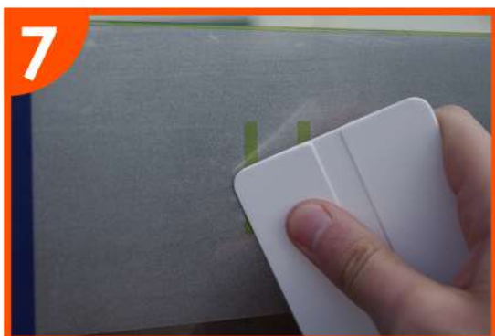
7. Chasser les bulles d'air grâce au racloir
