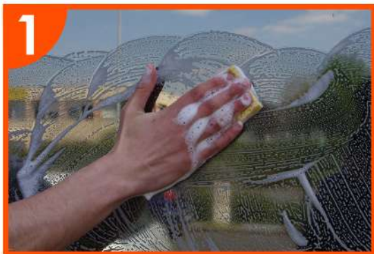
1. Nettoyer et dégraisser la surface de pose
