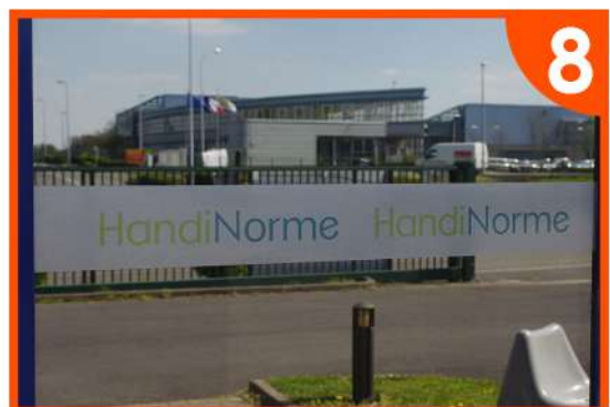
8. La pose est terminée. Si quelques bulles subsistent, percez les à l'aide d'une aiguille
