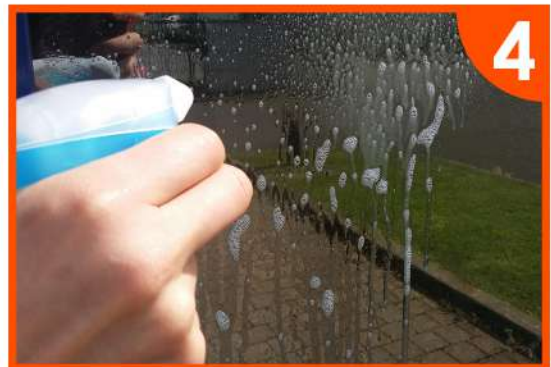
4. Vaporiser le savon sur la surface de pose pour faciliter le positionnement de l'adhésif
